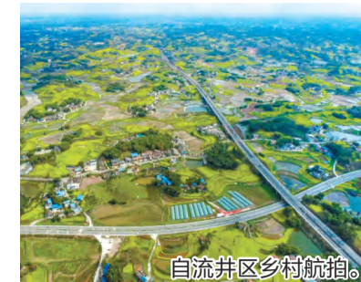
自流井区乡村航拍。
